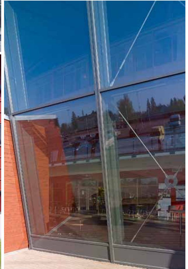
Snygga övergångar i ett komplext läge med speciellt utformade täckplåtar mellan de stora lutande och svängda glaspartier.
