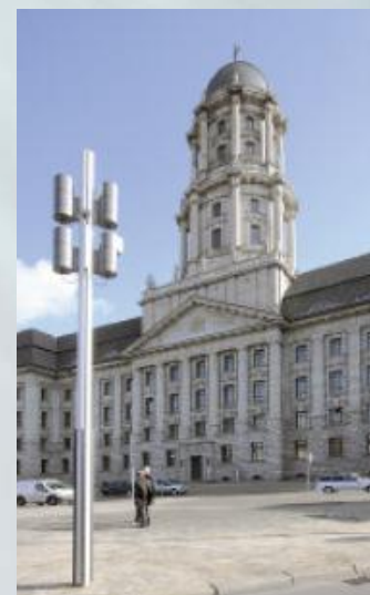
Fassadenleuchten, das Alte Stadhaus in Berlin-Mitte
