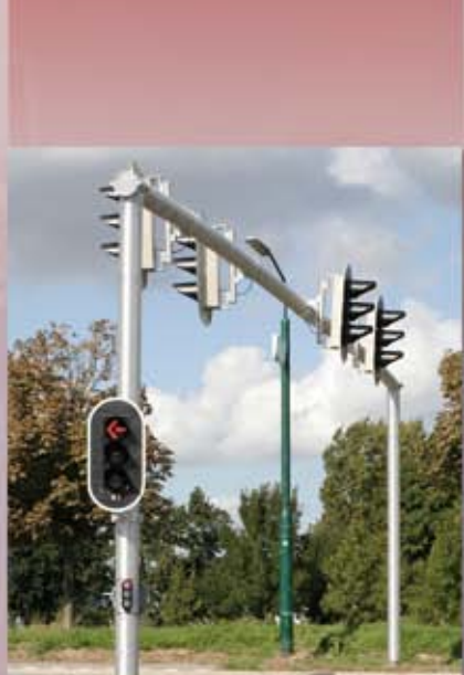
Portaal/ Overhead sign structure/ Schilderbrücken
