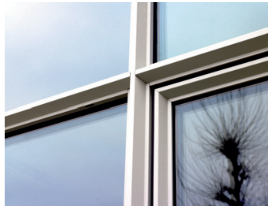
De sierlijke 'Ligna'-profielen laten zeer verfijnde constructies toe, die de grote glaspertijen in de gevels aan straatzijde optimaal tot hun recht laten komen.
