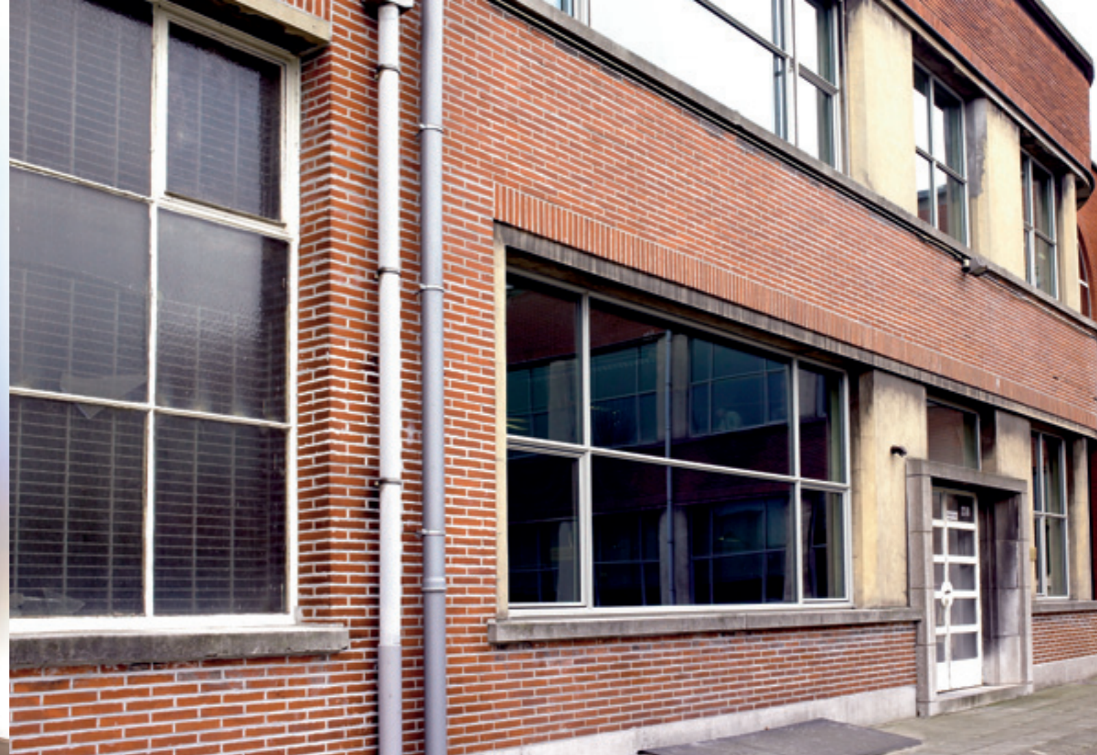
De fijne 'Ligna'-profielen van 'Sapa RC System (rechts) zijn visueel nauwelijks te onderscheiden van de oorspronkelijke stalen ramen (links), zodat het imposante architectuurbeeld aan de straatzijde volledig intact blijft, terwijl het nieuwe aluminium schrijnwerk optimaal presteert op het vlak van thermische isolatie.
