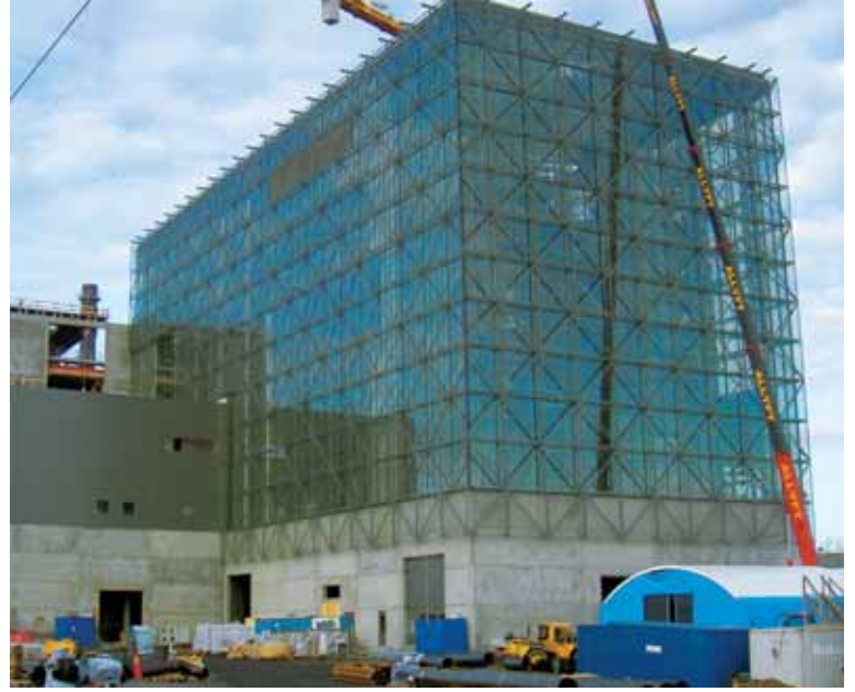
Getöntes Glas und Netze aus Aluminiumprofilen verleihen dem Gebäude einen besonderen Charakter. Gleichzeitig dienen sie als Sonnen- und Wärmeschutz.
