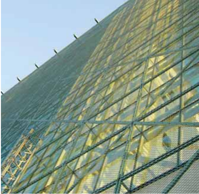
Getöntes Glas und Netze aus Aluminiumprofilen verleihen dem Gebäude einen besonderen Charakter. Gleichzeitig dienen sie als Sonnen- und Wärmeschutz.
