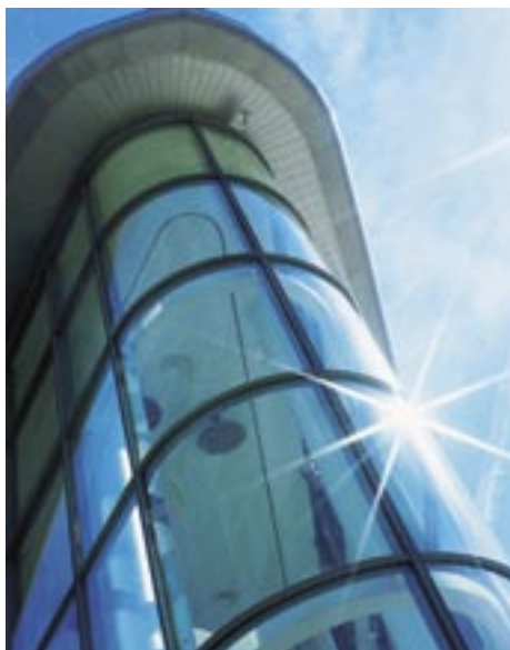
Großflächige Glaswände sorgen für Luft und Helligkeit
