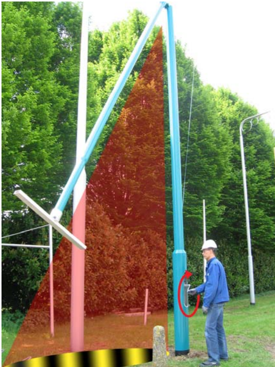
Afb. 13 Draai de lier rechtsom om de mast weer overeind te zetten. Let op , sta niet tussen de arm en de mast.
