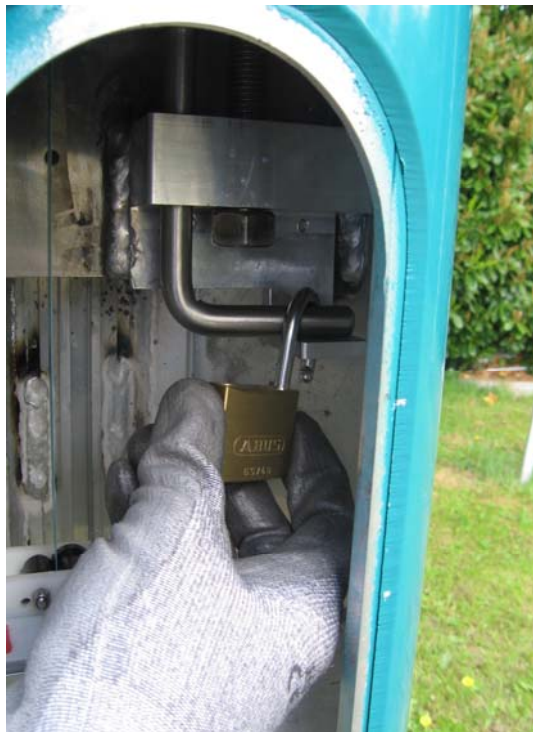
Afb. 19 Plaats het hangslot zodat deze de hendel blokkeert.
