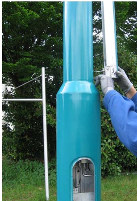
Afb.08 Brenge de arm met de hand tot net over het dode punt.
