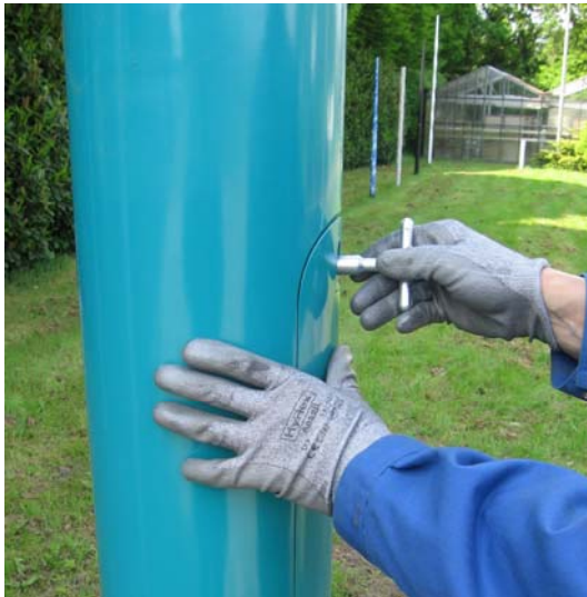
Afb.01 Draai de 2 speciaal bouten van de deur los.
