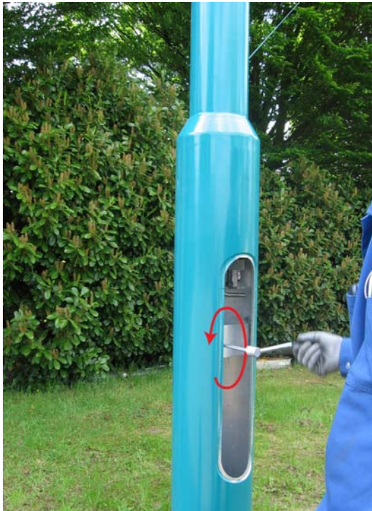
Afb.09 Laat de mast kantelen door de lier linksom te draaien.
