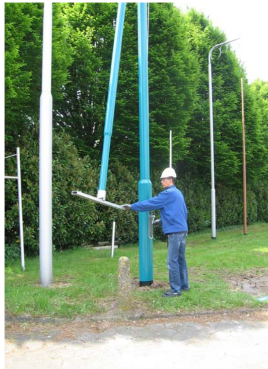
Afb.12 Draai door tot de mast tegen de aanslag gekanteld is. Let op dat de masttop niet doorveert!
