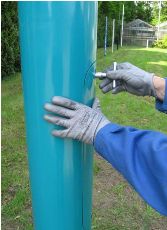
Afb.21 Draai de 2 speciaal bouten van de deur vast.
