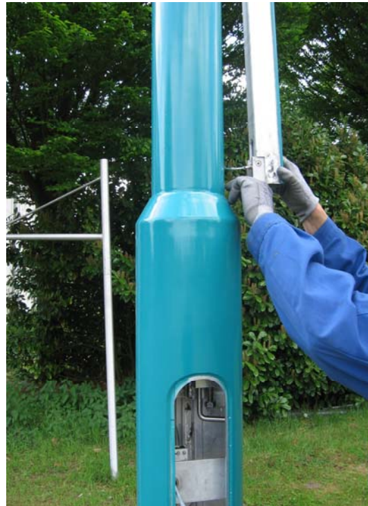
Afb. 14 Let er bij het laatste stuk op dat het lint niet verdraaid en zonder knikken de mast in gaat.
