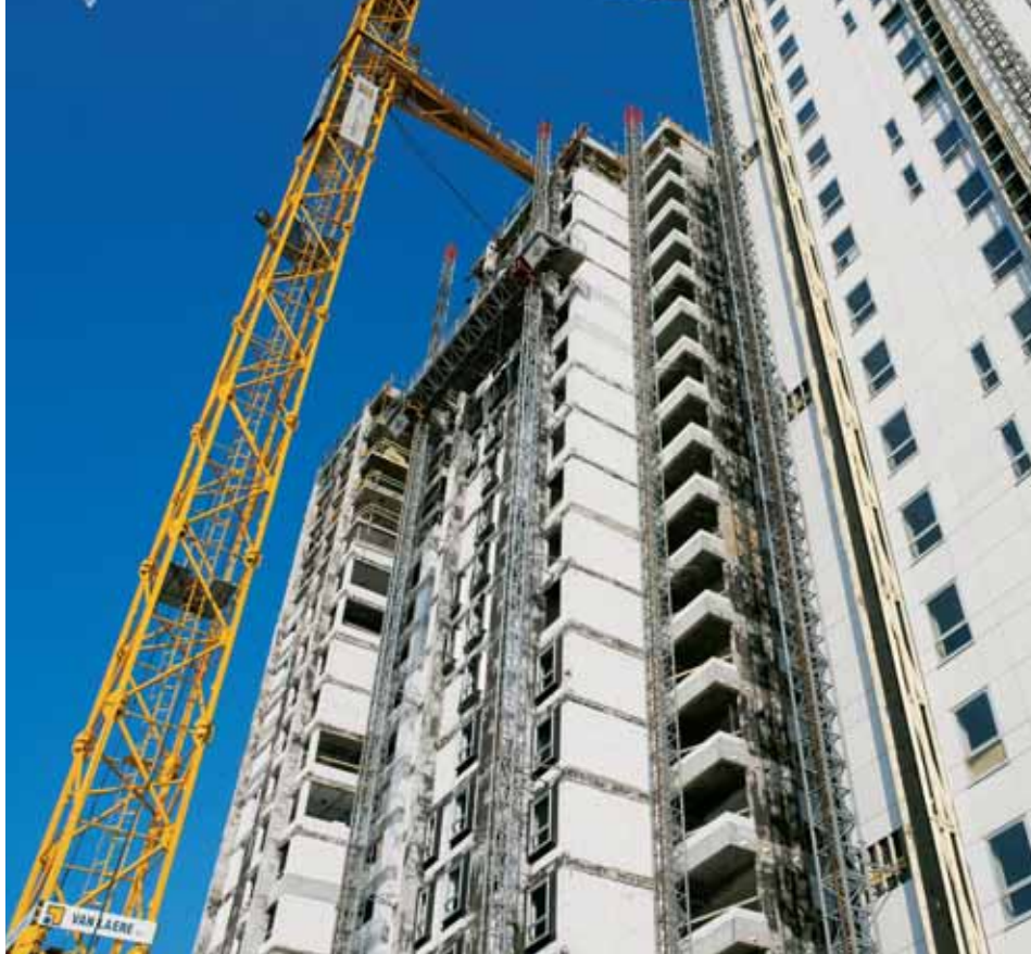
Bessere Geräuschdämmung und Wärmeisolierung dank neuer Fensterrahmen für die Silvertop Towers.
